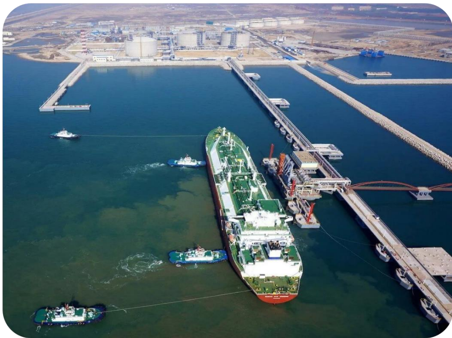
山东液化天然气（LNG）项目码头及陆域形成工程 国家优质工程奖
