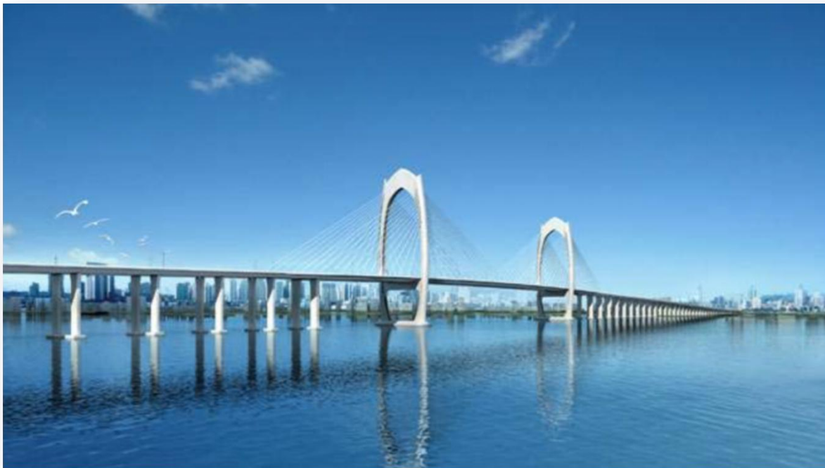
水东湾大桥新建工程
