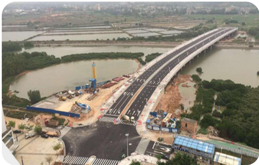
电白县县城海滨跨海大桥新建工程
