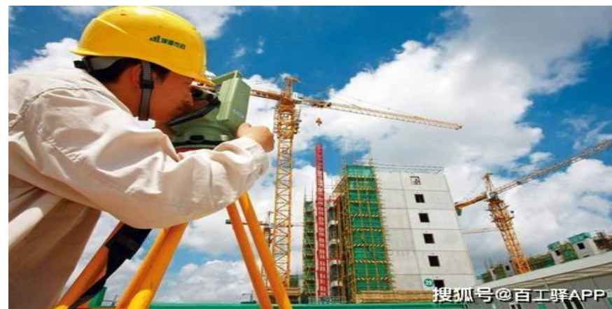
组织施工单位现场复验
