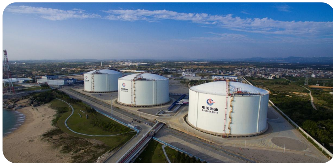
中海油粤东LNG项目 ( 3×16万m 3 全容积低温罐及配套接收站 )
