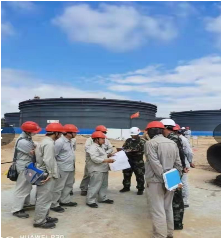
现场巡检，组织现场会议及协调 工作
